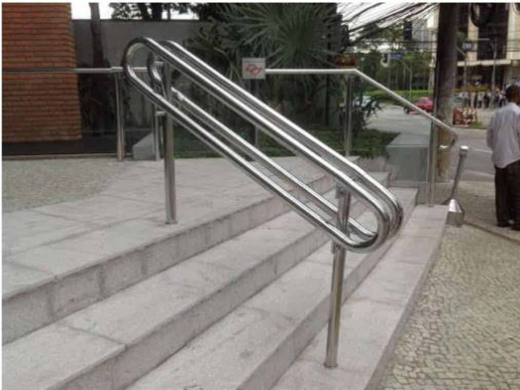
Imagem 01 - Representação do Corrimão Duplo com Duas Colunas. Neste Item Pede-se com Três Colunas, Sendo a 3ª Coluna Inserida Centralizada entre as Duas Existentes na Imagem.
